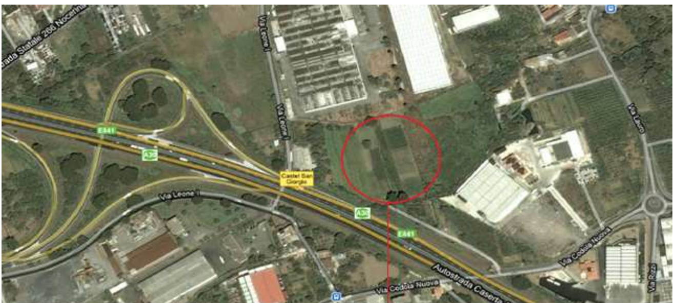
Aerofoto: particolare della futura localizzazione dell'opificio industriale determinata dalla variante urbanistica
